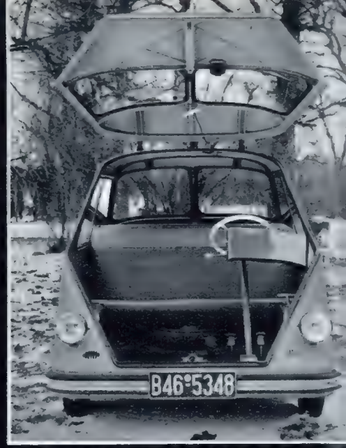
Zum Ein- und Aussteigen wird die Türe hochgeklappt. Es geht ganz bequem, weil die Türe federbelastet ist. Das Lenkrad und das kleine Armaturenbrett bleiben stehen, hindern aber nicht beim Einstieg.
